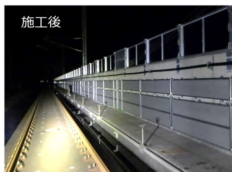
全天候型吸音材を使用した吸音板施工例（上越新幹線 散水区間）
