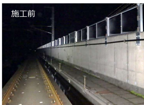
全天候型吸音材を使用した吸音板施工例（上越新幹線 散水区間）
